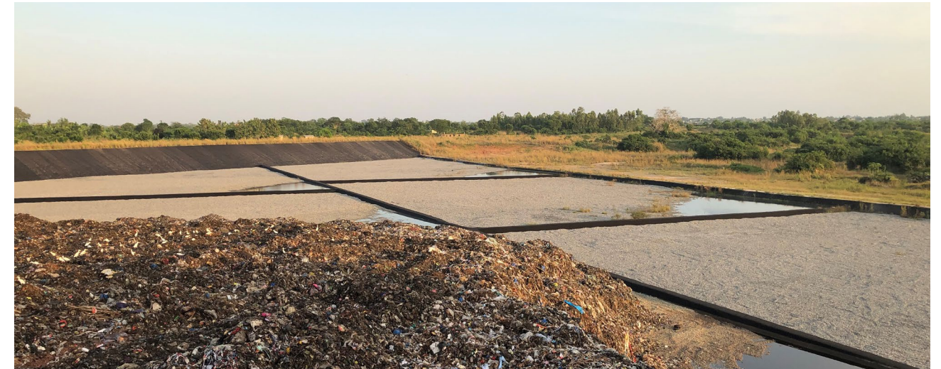
La gestion des déchets à Lomé : développement des services urbains
