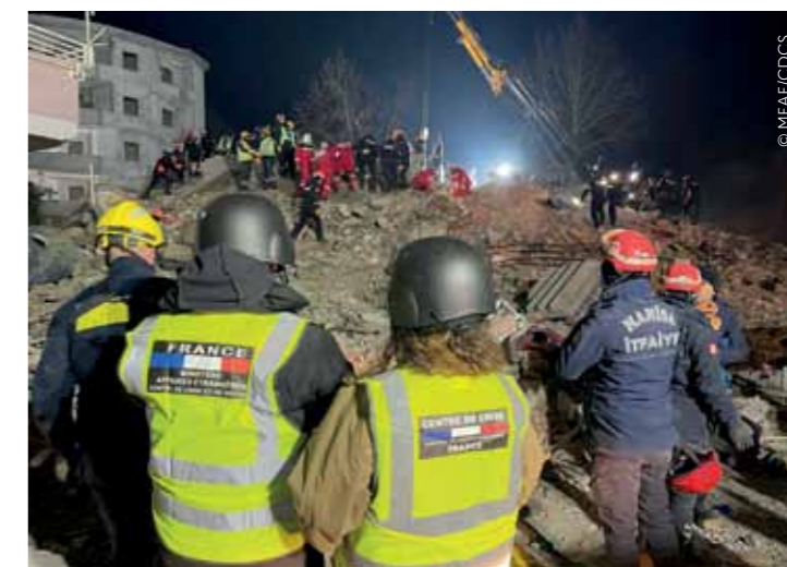
Séismes en Turquie - Intervention des équipes de la sécurité civile et du CDCS - février 2023
